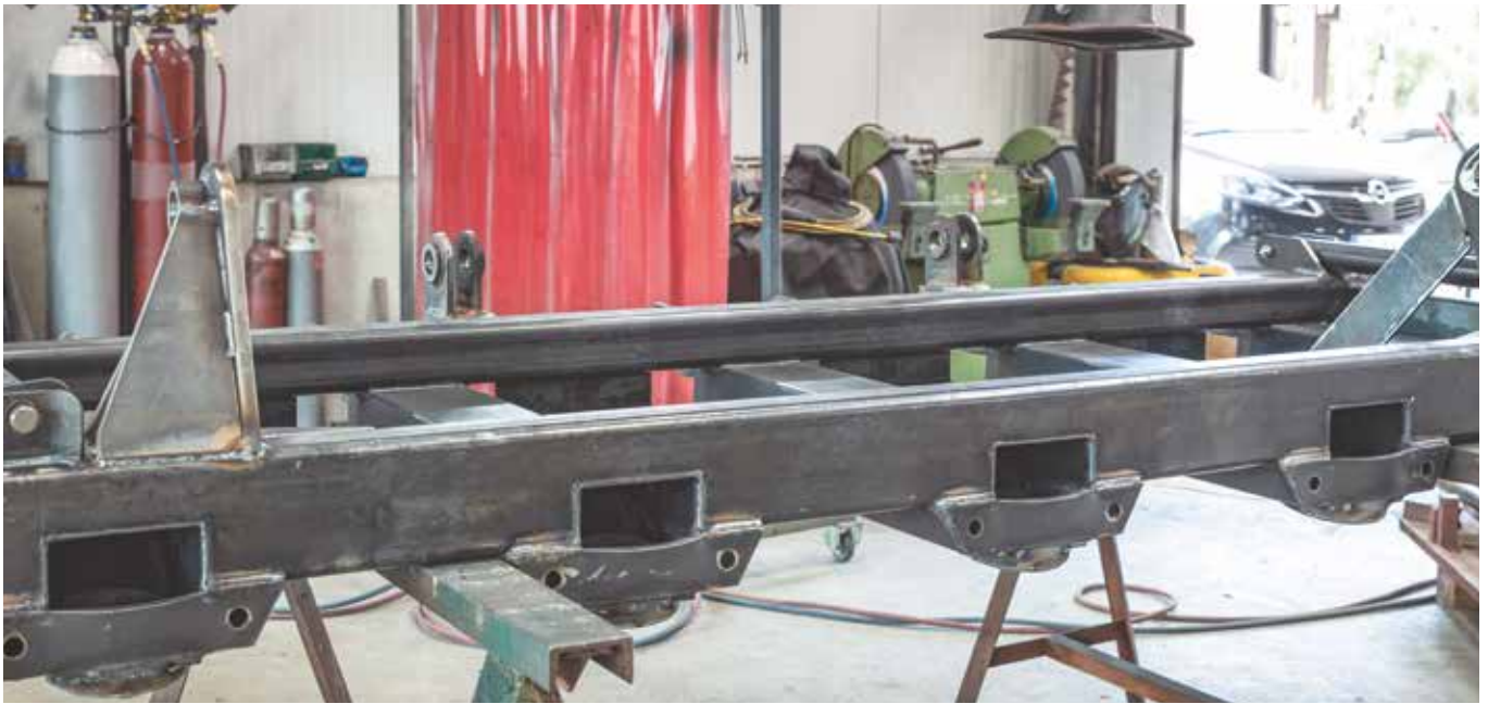
Jeden hotový díl svařovaný z velkého počtu řezaných dílů, které byly vyrobeny pomocí KNUTH Plasma Jet
